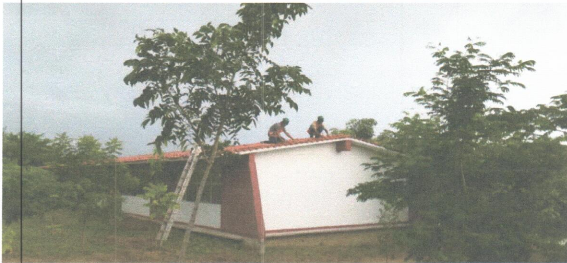
K EDIFICIO A
